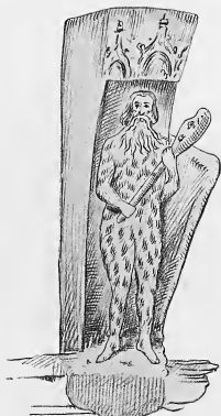
Poteau cornier de la rue du Grand-Pont, à Rouen (xvi e siècle)
